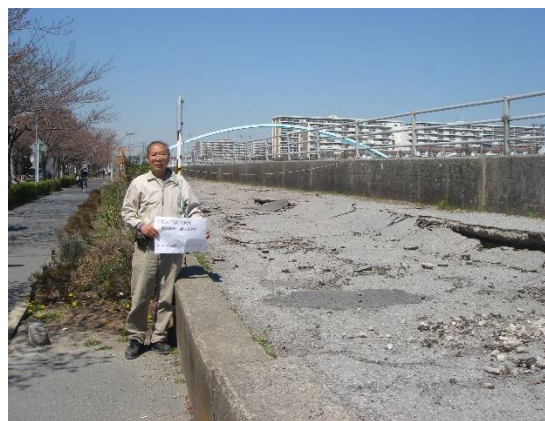
液状化被害(浦安にて)
