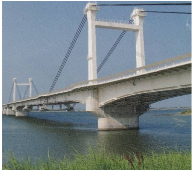
(完成した本橋)
