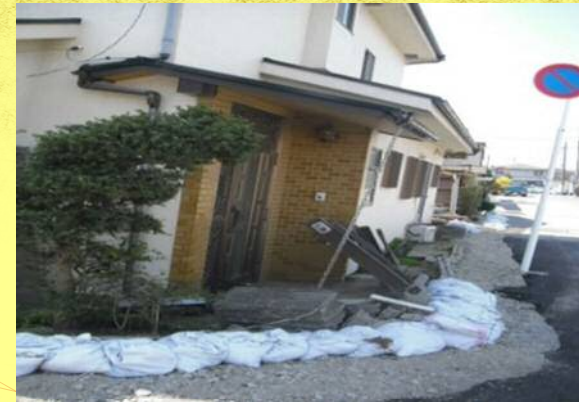
家屋の不等沈下と傾倒 (我孫子市布佐)
