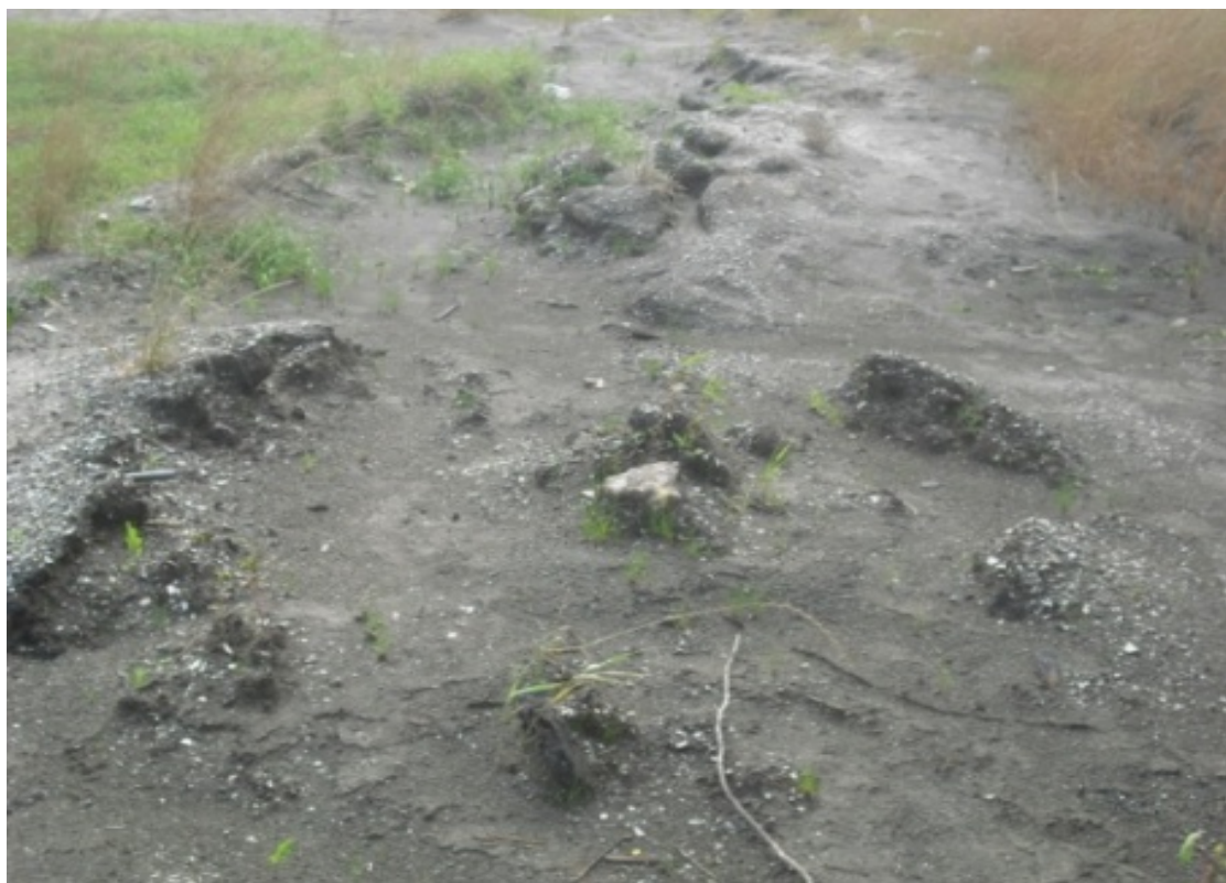
液状化による噴砂状況 (海岸方向:船橋三番瀬海岸)
