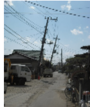
電柱の傾倒(我孫子市)
