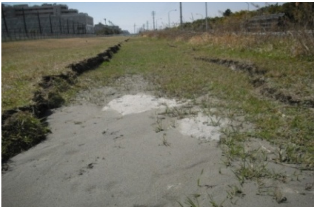
沈下による断層（幅2～3 m、延長約630～1 000m、 沈下15～35 c m、断層の亀裂幅10～20 c m）（明海大学横空地）
