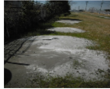
地盤の噴砂・噴水(浦安市)
