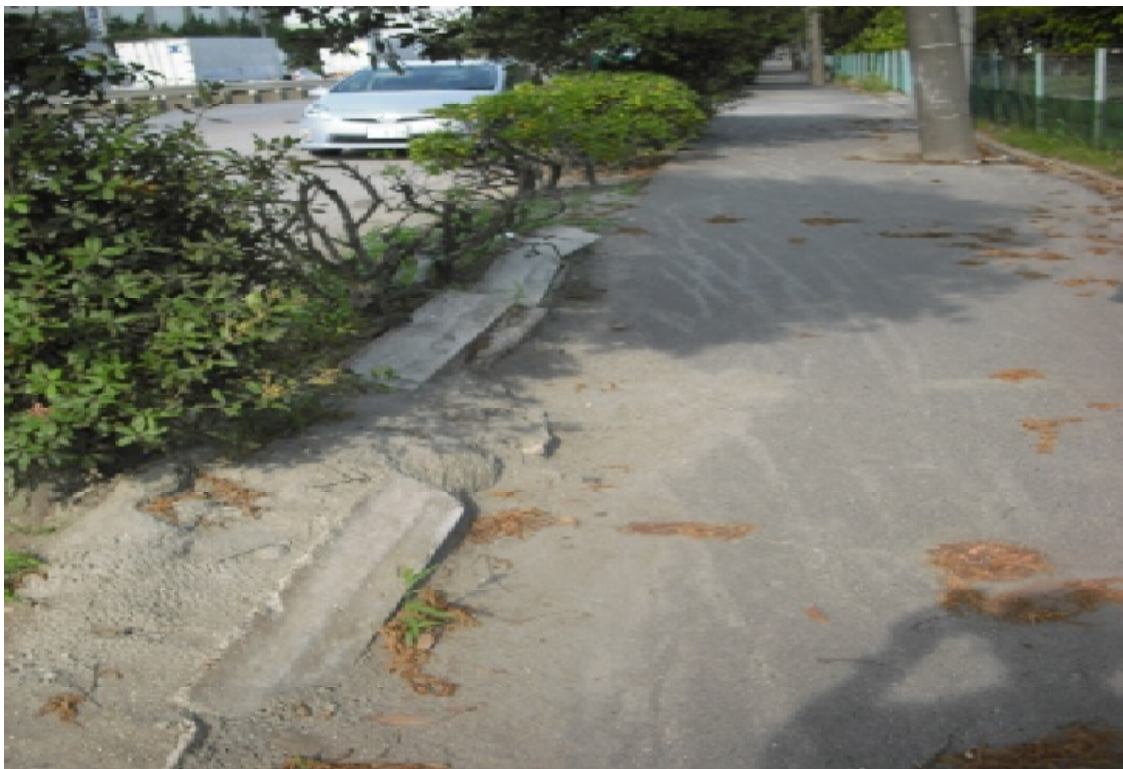
液状化による噴砂と植樹ブロック破壊(船橋海浜公園前歩道)
