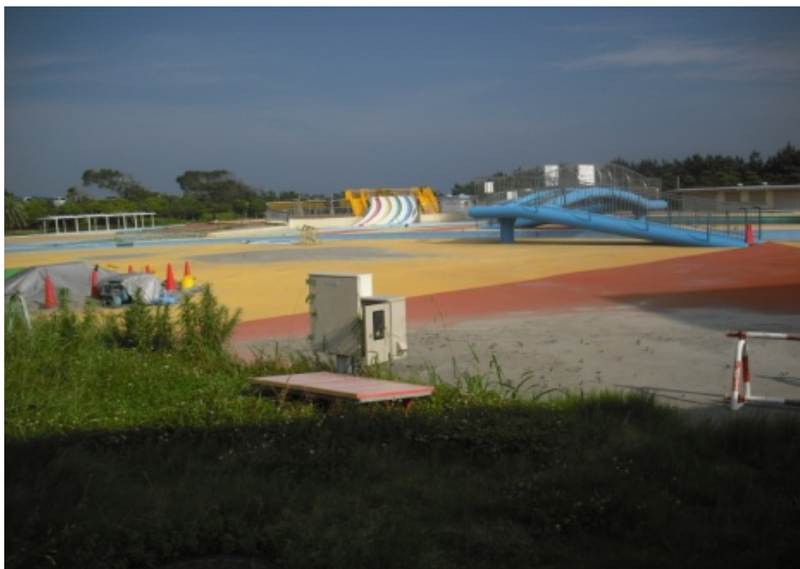
園内プール施設の状況(手前噴砂)(船橋海浜公園内)
