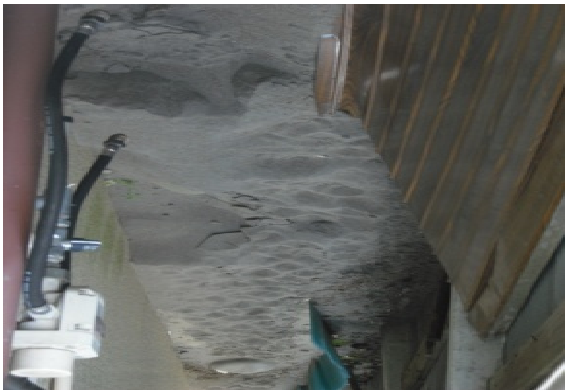
住宅地内の液状化による噴砂(今川町)
