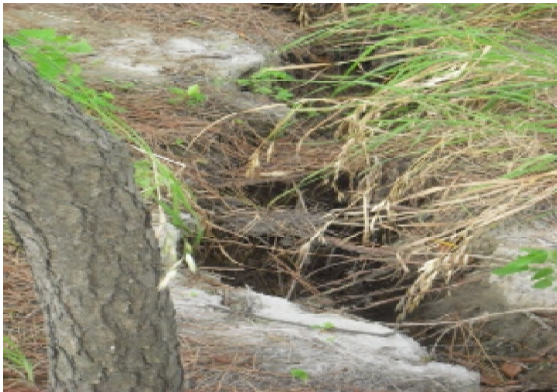
地盤の亀裂(幅40～50cm)護岸表～海岸方向(船橋三番瀬海岸)
