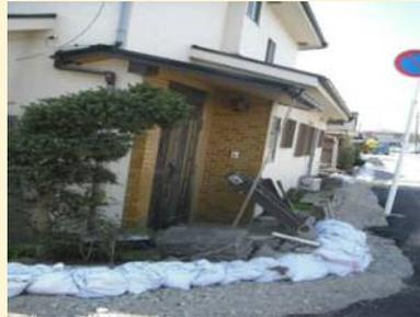
**①-1液状化による噴砂と建物の傾倒**
