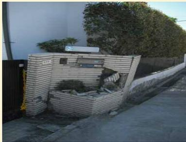
**②外構の沈下・傾倒:コンクリート門扉**
