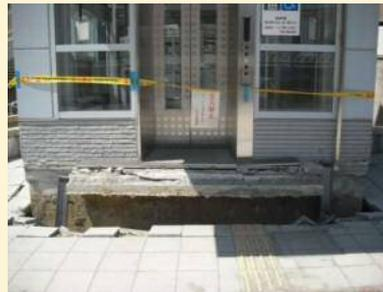
**③地盤の沈下と建物の杭基礎の露出(抜け上がり)**
