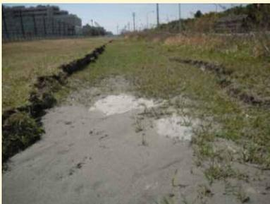
**④地盤の沈下と噴砂跡**
