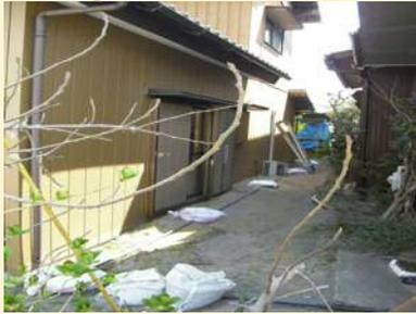
**①液状化による噴砂と建物の沈下**
