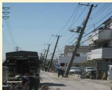
**④電柱の沈下・傾倒**
