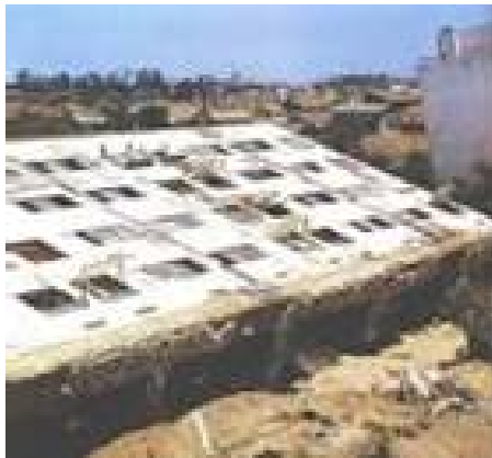
新潟地震 県営住宅転倒
