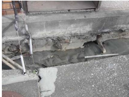
湾岸部（栄地区）液状化によりライフラインが切断
