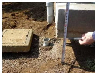
台地部（高根町）での液状化による段差（約 30 cm）発生
