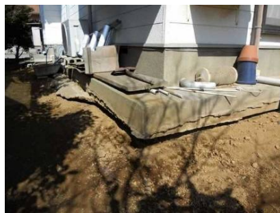
台地部（高根町）での液状化による段差（約 30 cm）発生
