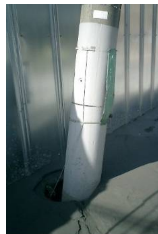
液状化で沈んだ電信柱
