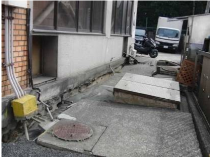
湾岸部（栄地区）液状化によりライフラインが切断
