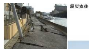
液状化で沈んだ電信柱
