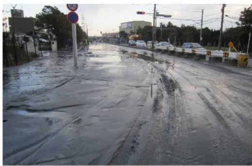
潮見町では広い範囲で液状化の被害を受けた
